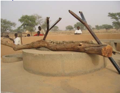
Un puits en cours de réalisation
